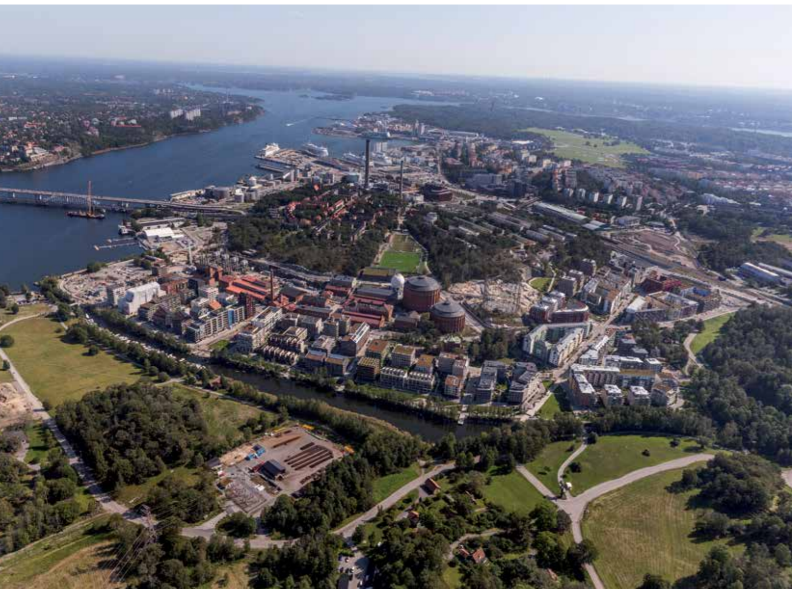
Gasverksområdet, Stockholm (Photo Lennart Johansson, Statdsbyggnadskontoret, Stockholms stad, 2019, Flickr, CC BY)
