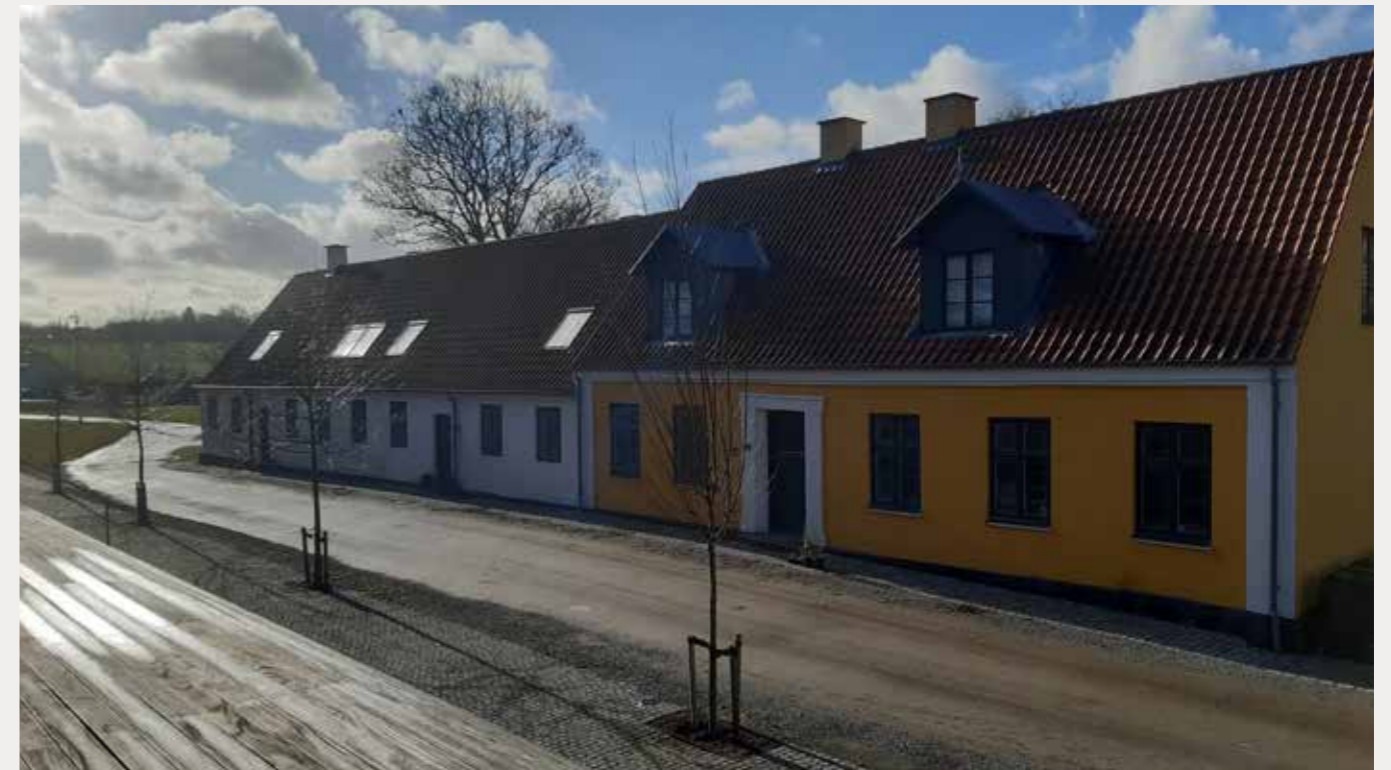
Fig. 7. Skolebygningen fra 1865. Den gulkalkede del er opført efter en brand i 1904. I dag benyttes bygningen til beboelse. Foto: JHC 2022.
