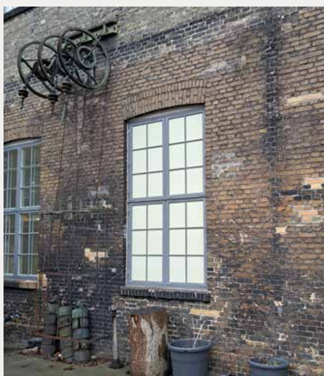
Fig. 25. Rester af gamle tovspele på Drejerværkstedets gårdfacade. Foto: JHC 2023.
