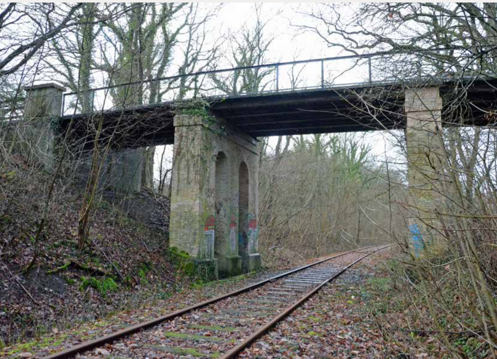
Flere steder langs banen passerer banen over vandløb. Broerne er bygget ved banens anlæggelse og har igennem årene gennemgået forskellige mindre istandsættelser og moderniseringer. Foto: Lars Bjarke Christensen.
