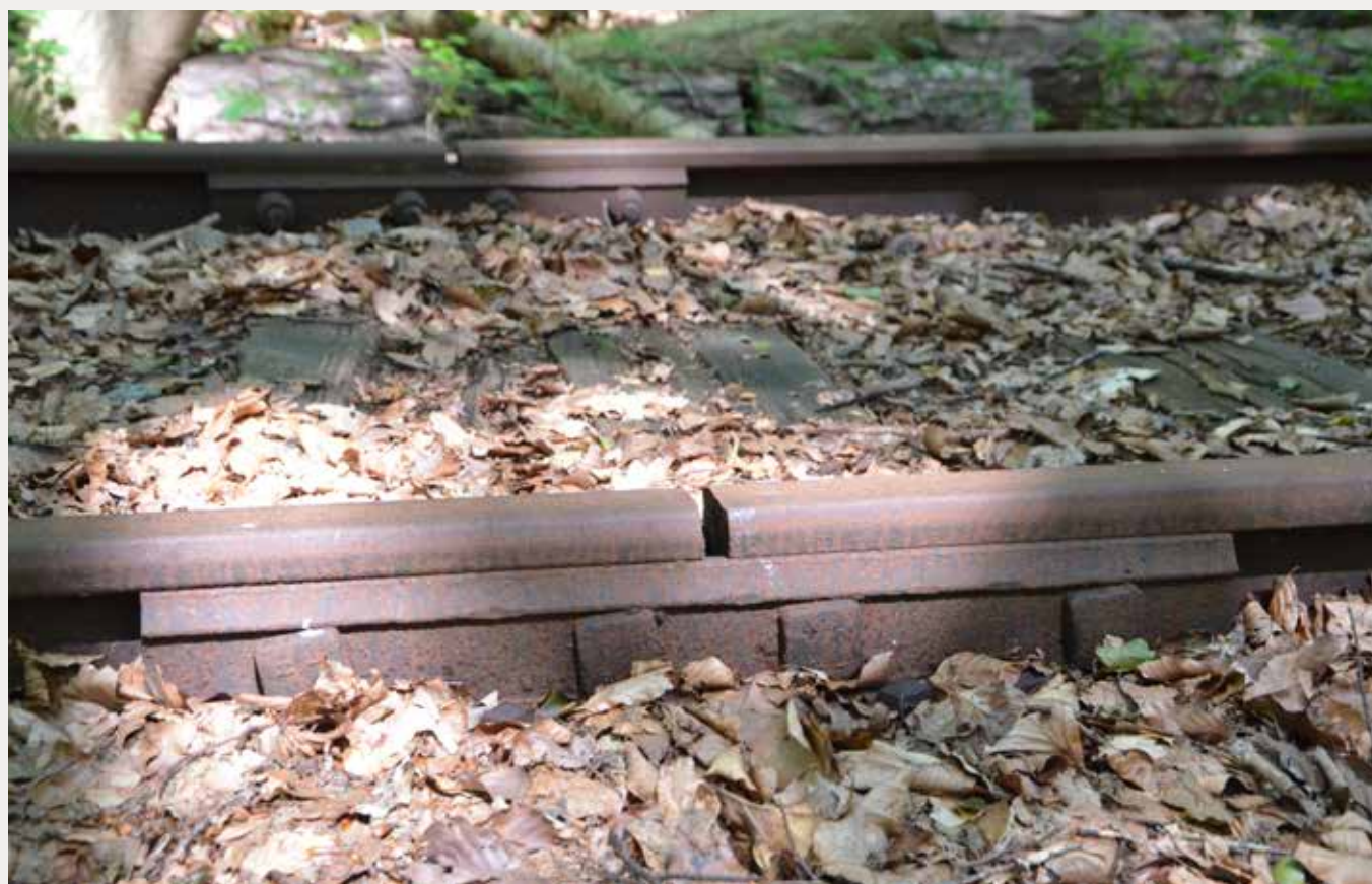
Skindestød på Aabenraabane hvor to jernbaneskiner er fastgjort til hinanden. De korte jernbanespor gav i ældre tid anledning til togenes karakteristiske gang i sporet, hvor den rejsende både mærkede og hørte når togets hjul passede over skindestødet. Foto: Lars Bjarke Christensen
