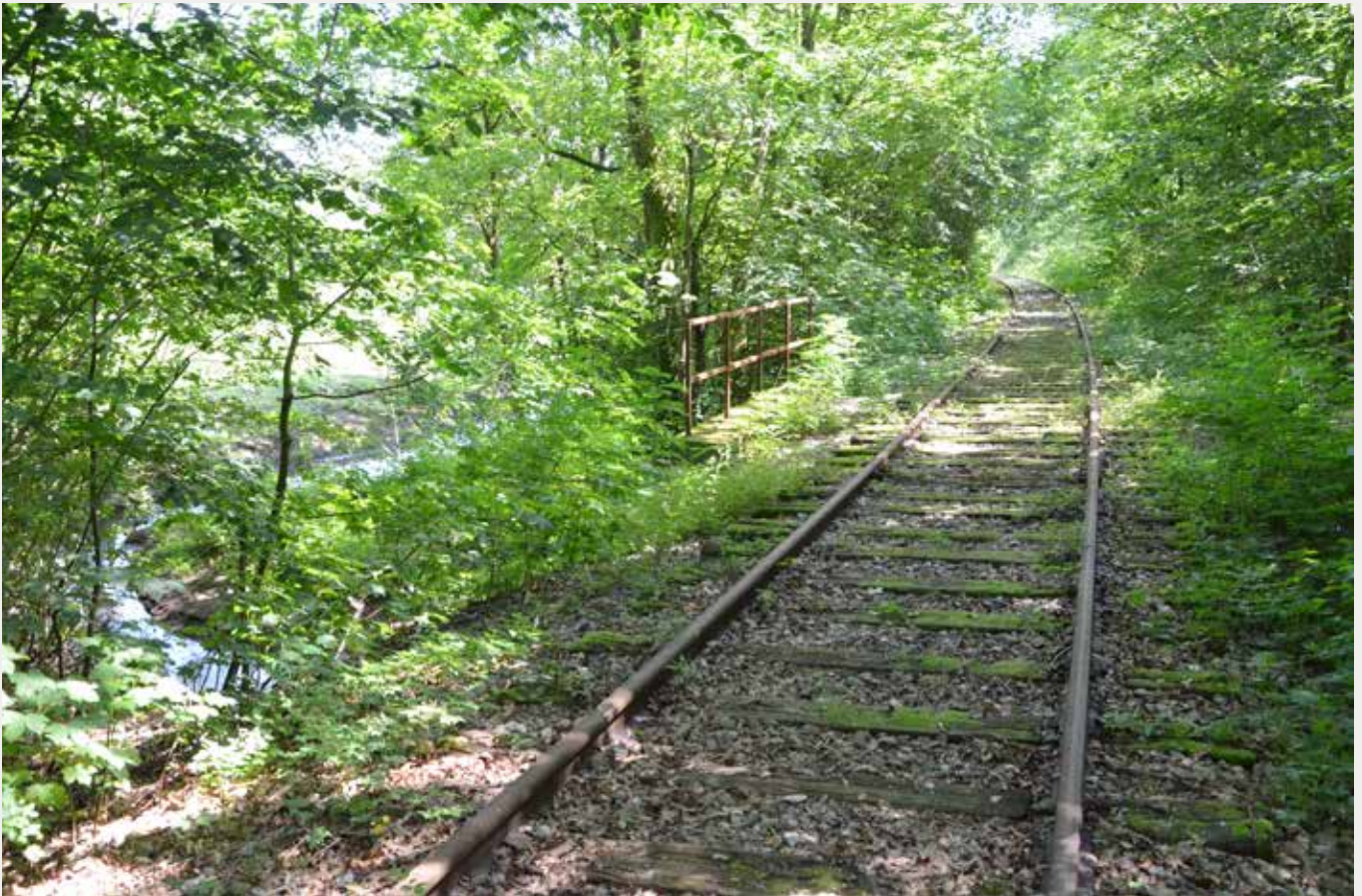
Flere steder langs banen passerer banen over vandløb. Broerne er bygget ved banens anlæggelse og har igennem årene gennemgået forskellige mindre istandsættelser og moderniseringer. Foto: Lars Bjarke Christensen.
