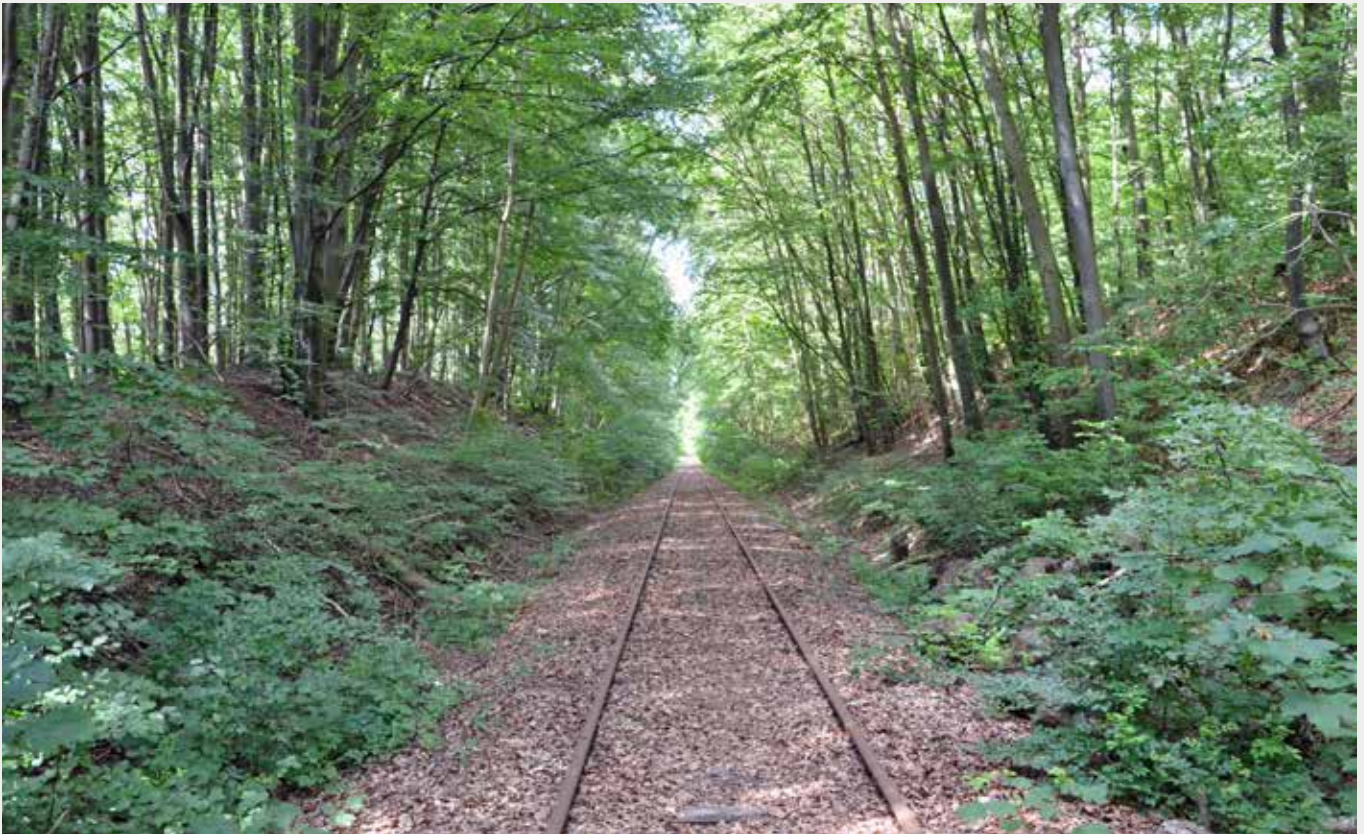
Den enkeltsporede jernbanestrækning går gennem et varieret landskab. Visse steder var det nødvendigt at grave ned i terrænet ved anlæggelsen af banen for at etablere et jævnt fald/stigning på banen. Foto: Lars Bjarke Christensen.
