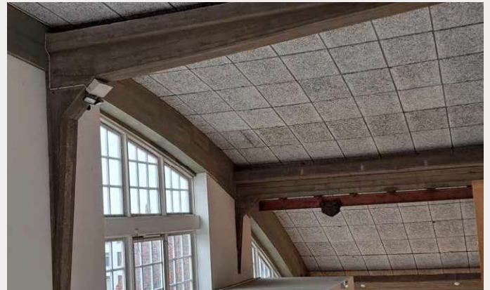
Fig. 27. Den elegante jernbetonkonstruktion med segmentbuer og tværgående dragere. Foto JHC.
