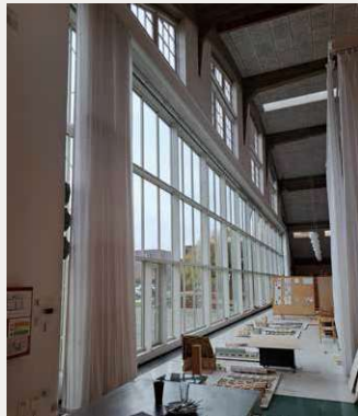
Fig. 25. Den dobbelte glasslydeport, der kan åbne hangaren i fuld bredde ud mod den store terrasse, august 2022. Foto Jørgen Hegner Christiansen (JHC).
