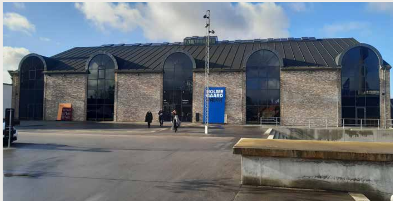
Fig. 13. Modtagelsesbygningen, opført 2006. Foto: JHC 2022.
