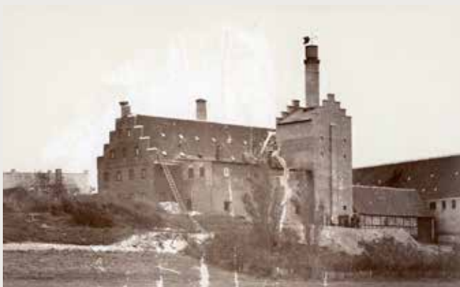
Fabrikens første malkølle med kamtakket gavl og udluftningskorsten blev tilbygget det gamle pakhus i 1895. Foto: Ebeltoft Byhistoriske Arkiv, ca. 1900.
