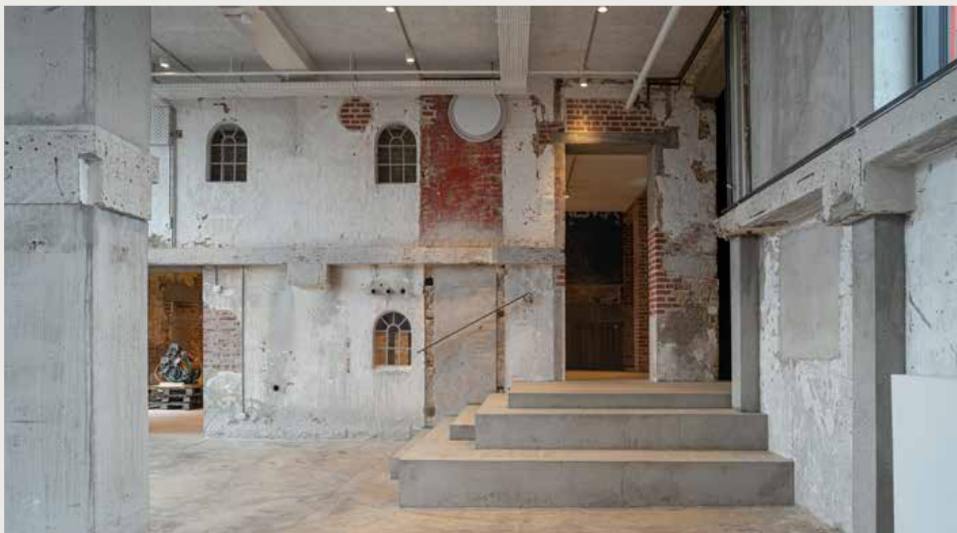
Nedgangen til børnebiblioteket i stueetagen i sydføljen før indretningen. Resterne af det fjernede etagedæk er meget synlige, men illustrerer med al tydelighed hvad der kan opnås ved indgrebet. Foto: Jens Markus Lindhe.
