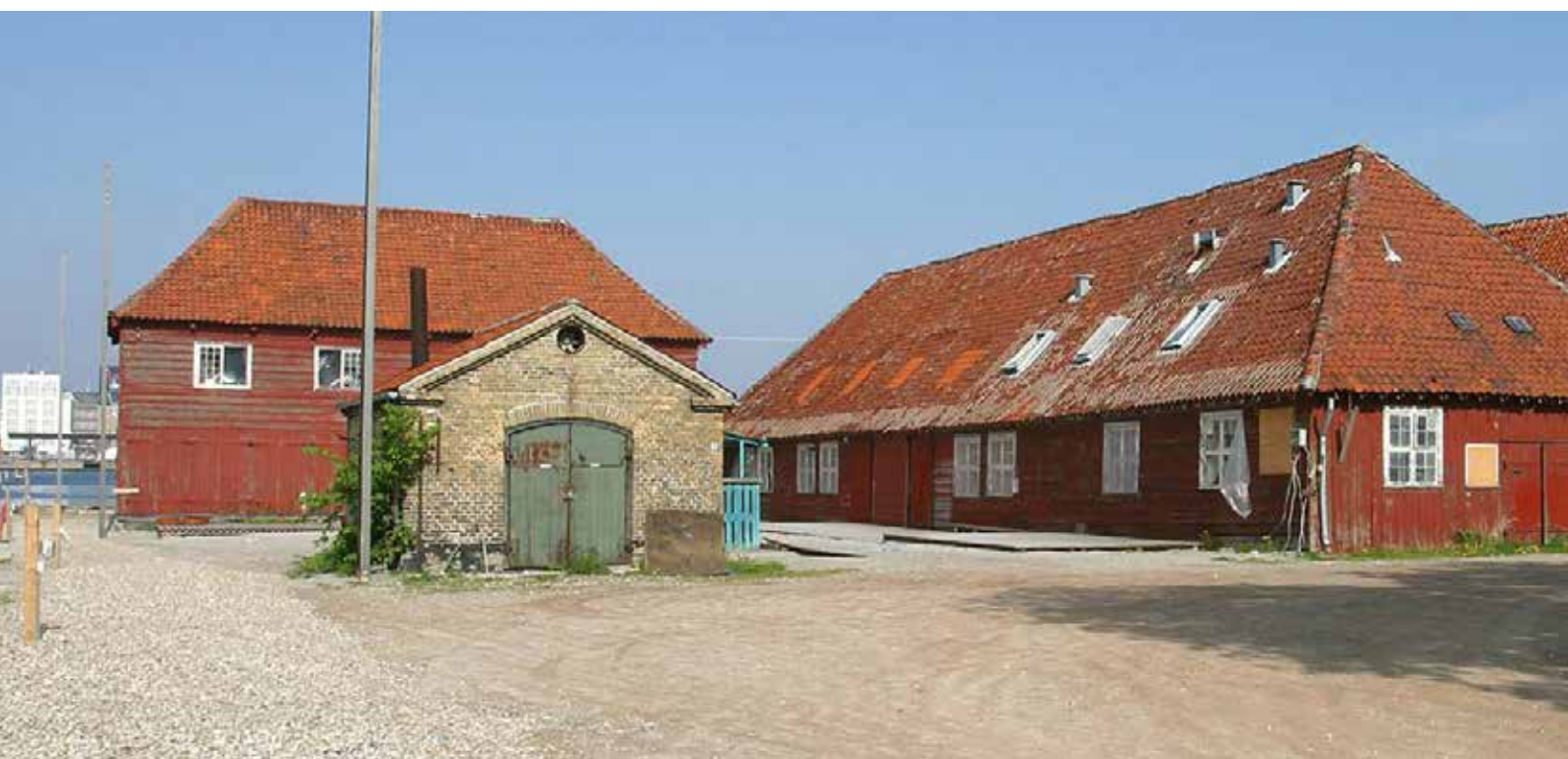
Søndre Masteskure og Mærsehuset før restaureringen. Fotograf: Andreas Trier Mørch / Arkitekturbilleder.dk
