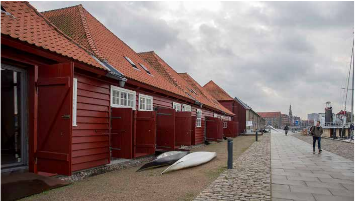
Søndre Masteskure – Vestfacaden mod havnen efter restaureringen med ældre porte og vinduer med håndmedede beslag. Bygningen er uden tagrender og nedløb og vandet fra tagfladerne ledes væk gennem pikstensbelagt rende. Som en konsekvens af den nyanlagte hævede vej ud mod havnen gav fredningsmyndighederne tilladelse til at hæve Masteskurene 84 cm i forhold til det oprindelige niveau, for at bygningerne fortsat skulle indgå i et logisk samspil med omgivelserne. Fotograf: Sandra Gonon / Arkitekturbilleder.dk
