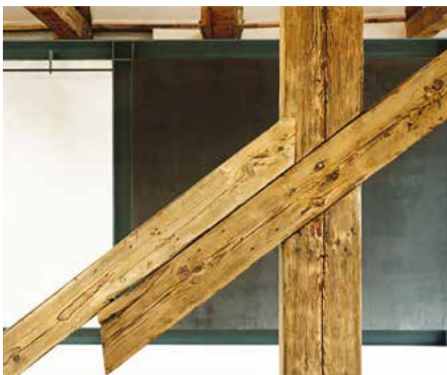
108 Søndre Masteskure. Ældre tømmerkonstruktion og bagvedliggende ny "funktionsboks" Foto: Arkitektfirmaet Frank Maali & Gemma Lalanda MLA/S
