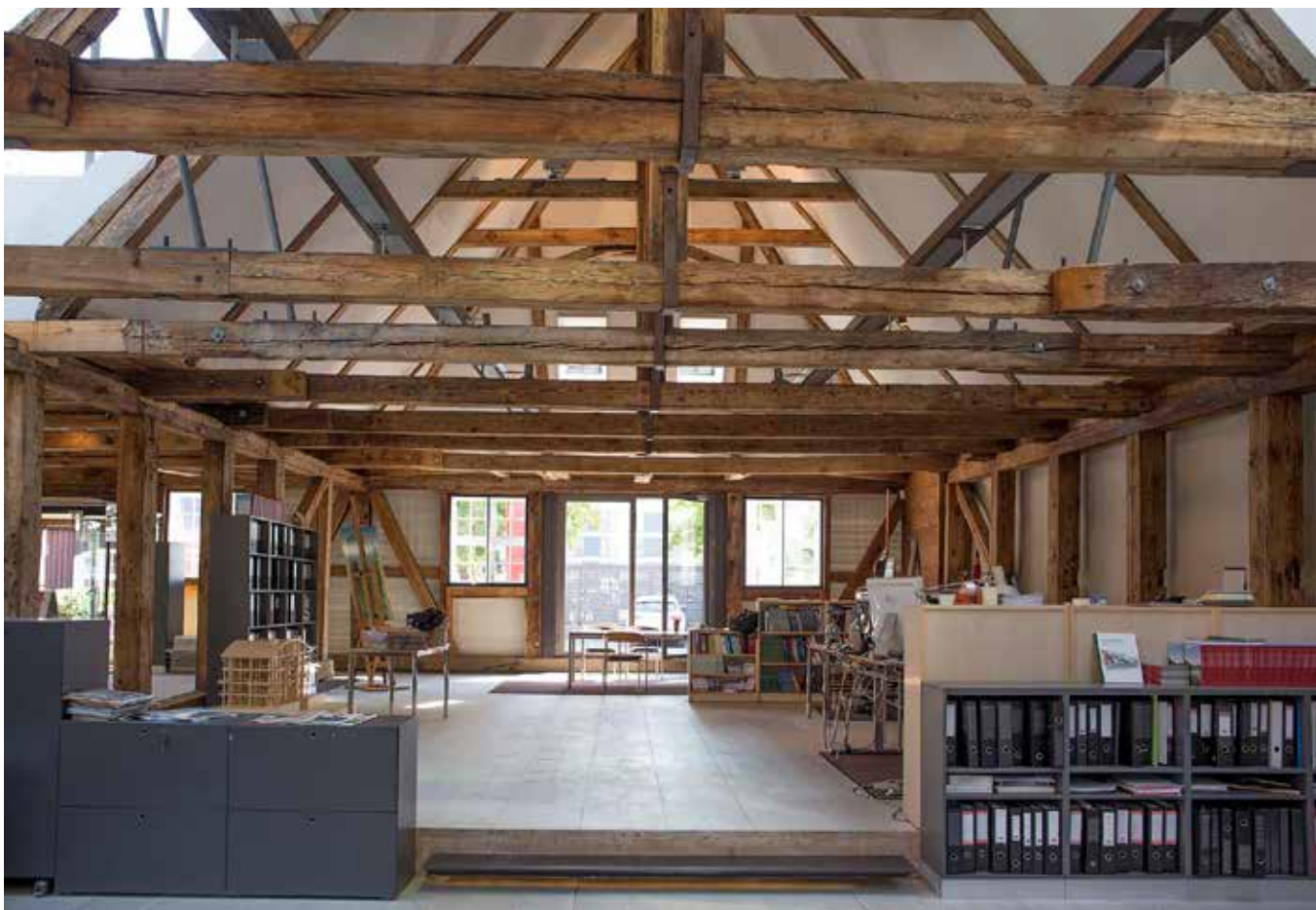
På grund af det særlige isoleringsprincip med termoglas på ydersiden af bindingsværkskonstruktionen oplever man stadig bindingsværkskonstruktionen i Masteskurene interieur. Dette var et krav fra fredningsmyndighederne for at give tilladelse til omdannelse fra en kold uisolereet bygning til en opvarmet bygning. Fotograf: Sandra Gonon / Arkitekturbilleder.dk
