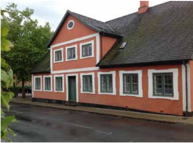
Stutmesterboligen i Hillerød kan være et af de forbilleder som J.F. Classen har haft for sine arbejderboliger i Frederiksværk. Foto forfatteren.
