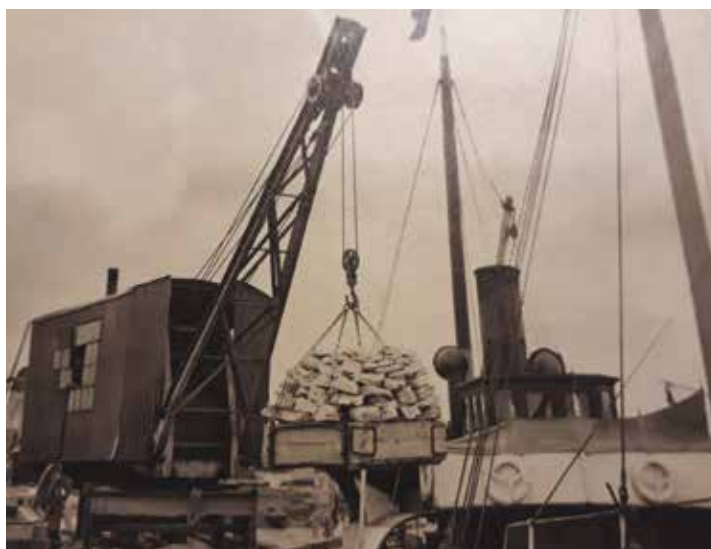
Lastning av kalksten vid Storugns 1909. Skånska Cements fotosamling, Landsarkivet i Lund.
