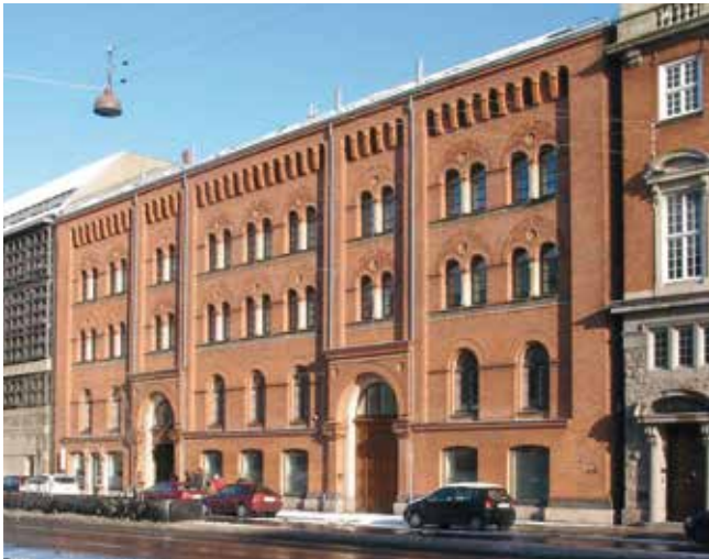
København, Grøns Varepakhús fra 1863 af D. Herhold, foto CAJ 2007 og plan af 2. og 1. loft samt snit efter Herhold-værket.
