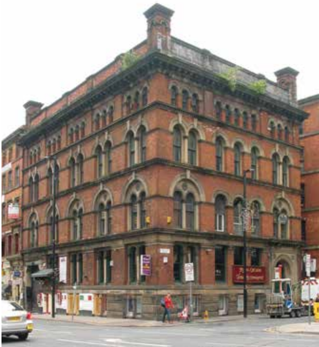
Manchester, Charlotte Street på hjørnet af Portland Street, Warehouse fra 1855-56 tegnet af Edward Walters.
