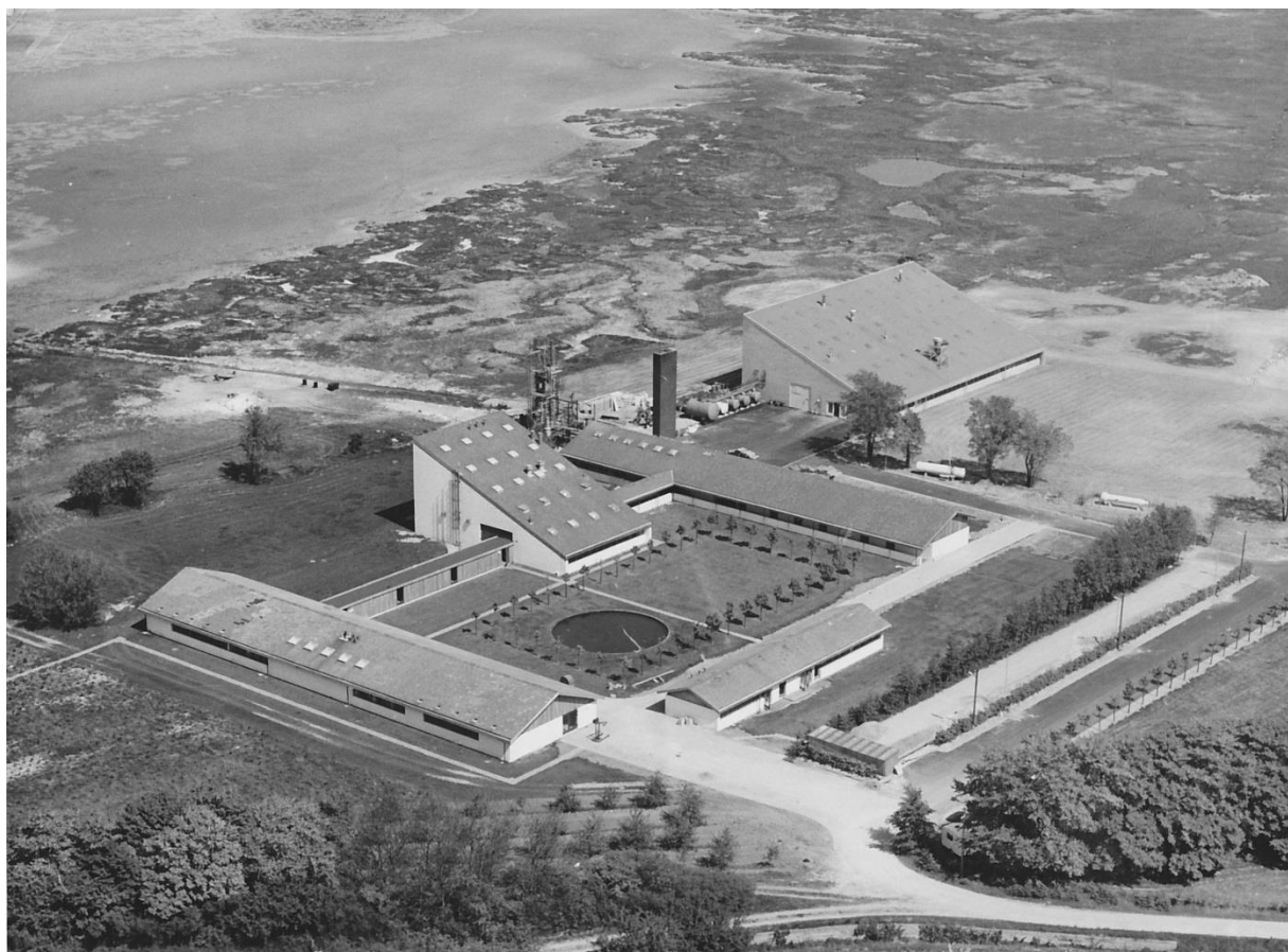
Haldor Topsøes katalysator- og siliciumfabrik i Frederikssund, i dag kendt som Topsil Semiconductor Materials A/S, som fabrikkomplekset tog sig ud ved midten af 1960'erne. Fremstillingen af siliciumkrystaller foregik i den lange bygning i forgrunden, mens råmaterialet (polykrystalinsk silicium), blev fremstillet i skråtagsbygningen i midten af komplekset. Fotoet er venligst stillet til rådighed af Arne V. Jensen.
