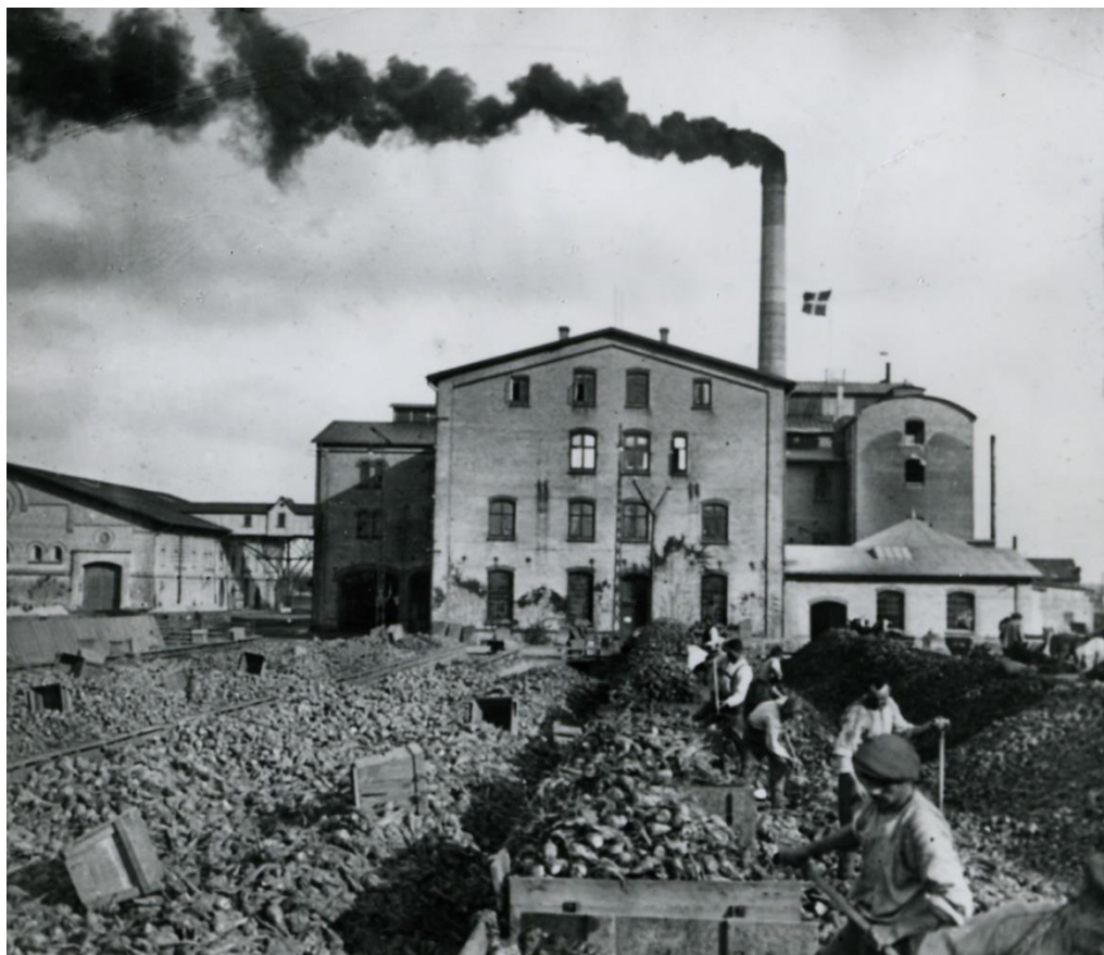
På sukkerfabrikkerne blev sukkerroerne læsset med håndkraft fra roetogenes vogne ned i fabrikkens flyderender. Her Maribo Sukkerfabrik ca. 1910. Foto: Museum Lolland-Falster.
