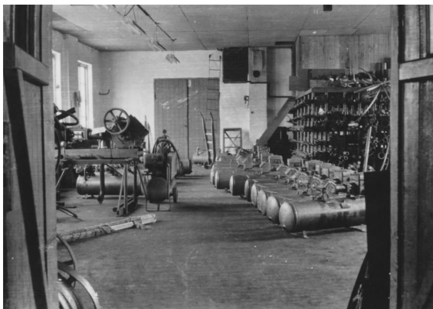
Pladskrævende og materialetunge stempelpumper i 1950 og den meget mindre centrifugalpumpe i 1959 ved siden af Poul Due Jensen. Centrifugalpumpens mindre dele muliggjorde rationalisering af produktionen.
