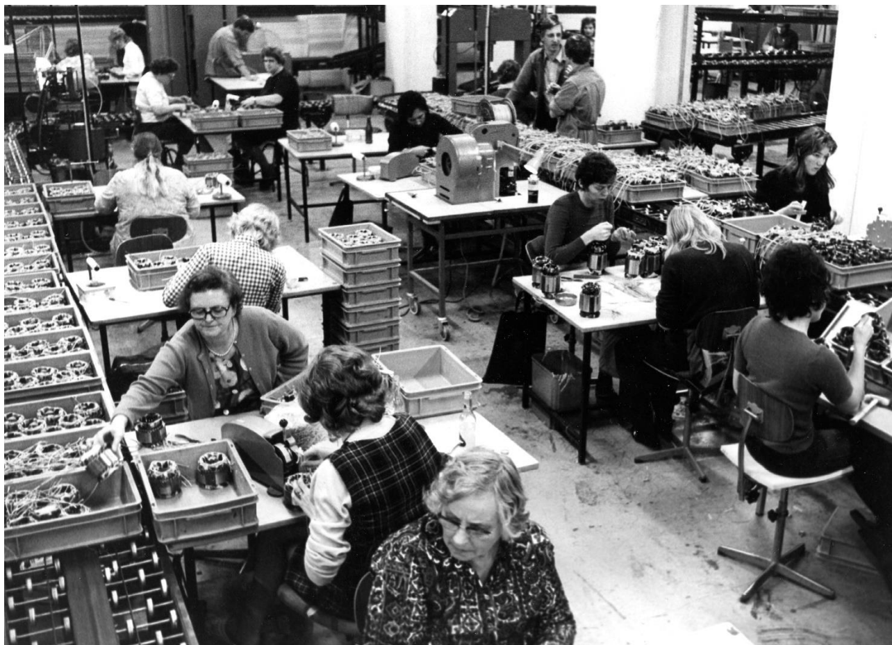
Medarbejdere i motorfabrikken i 1973. Kvinderne vikled tynd kobbertråd om motorens stator, og blev kaldt 'vikledamer'.
