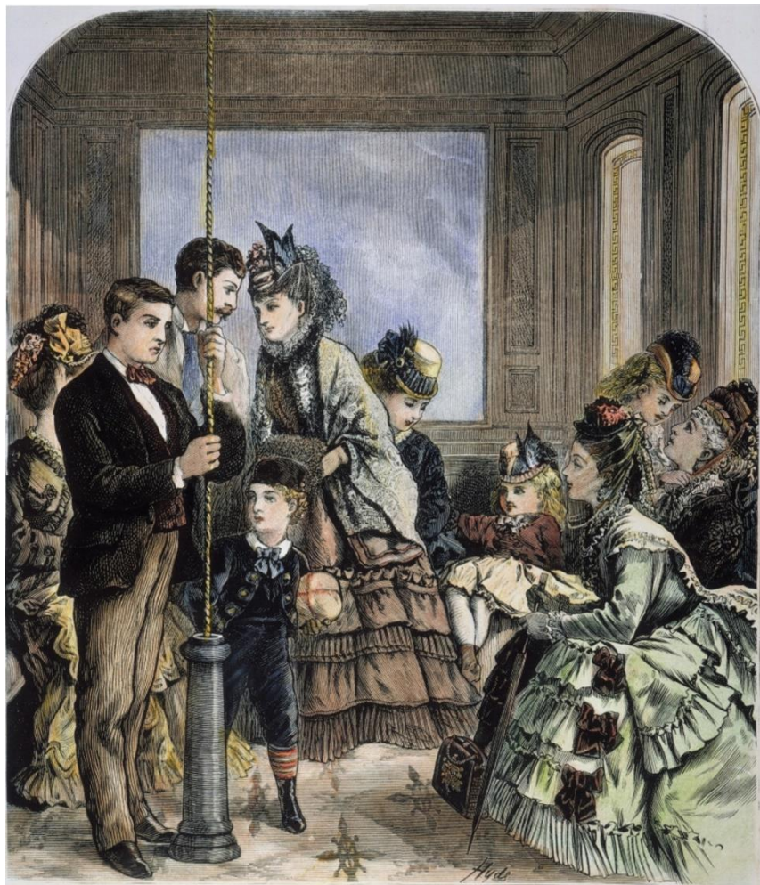
I det håndkolorerede træsnit vises åbningsdagen for en personelevator, som Otis installerede i et varehus i New York i 1872. Bemærk rebet gennem elevatorstolen, som elevatorføreren kunne styre elevatoren med.
