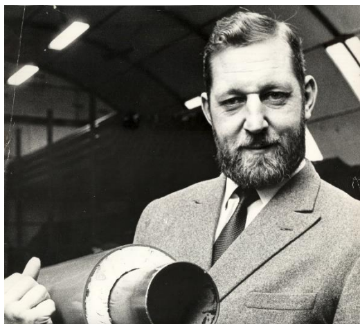
Ege Andersen fotograferet med et isoleret fjernvarmerør i slutningen af 1960'erne. Løgstør Lokalarkiv.
