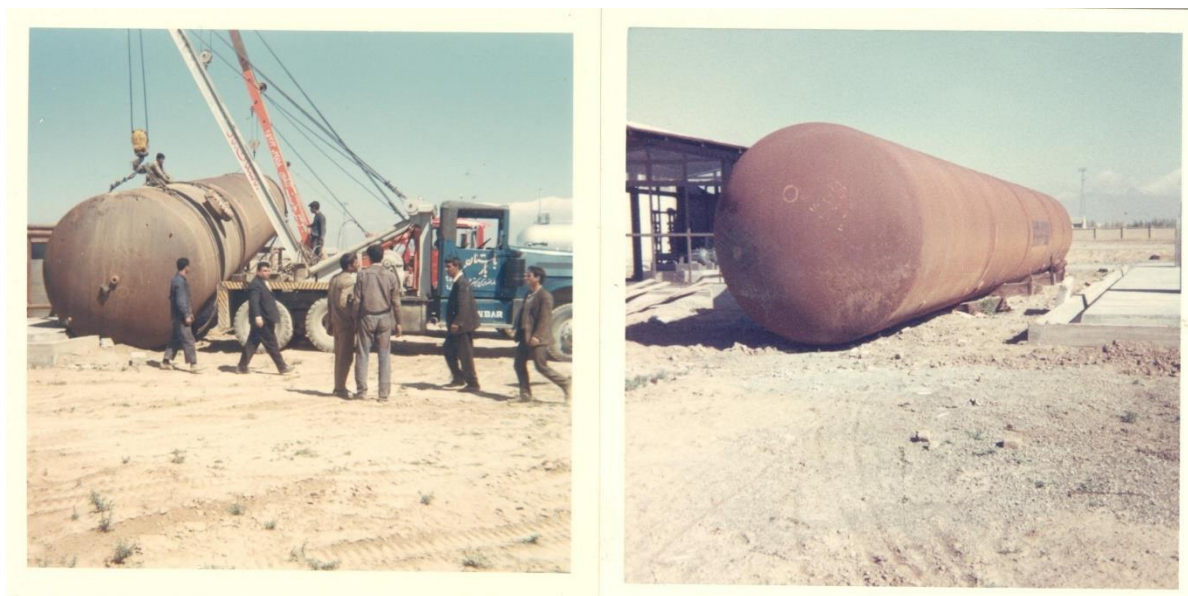
Iran – 1976. Rejse for Crisplant i Iran, hvor en ny tank til LPG-gas. Her ses flytningen af den 23 meter lange og ca. 50 tons tunge tank blive flyttet op et fundament. Fotos: Preben Olsen.
