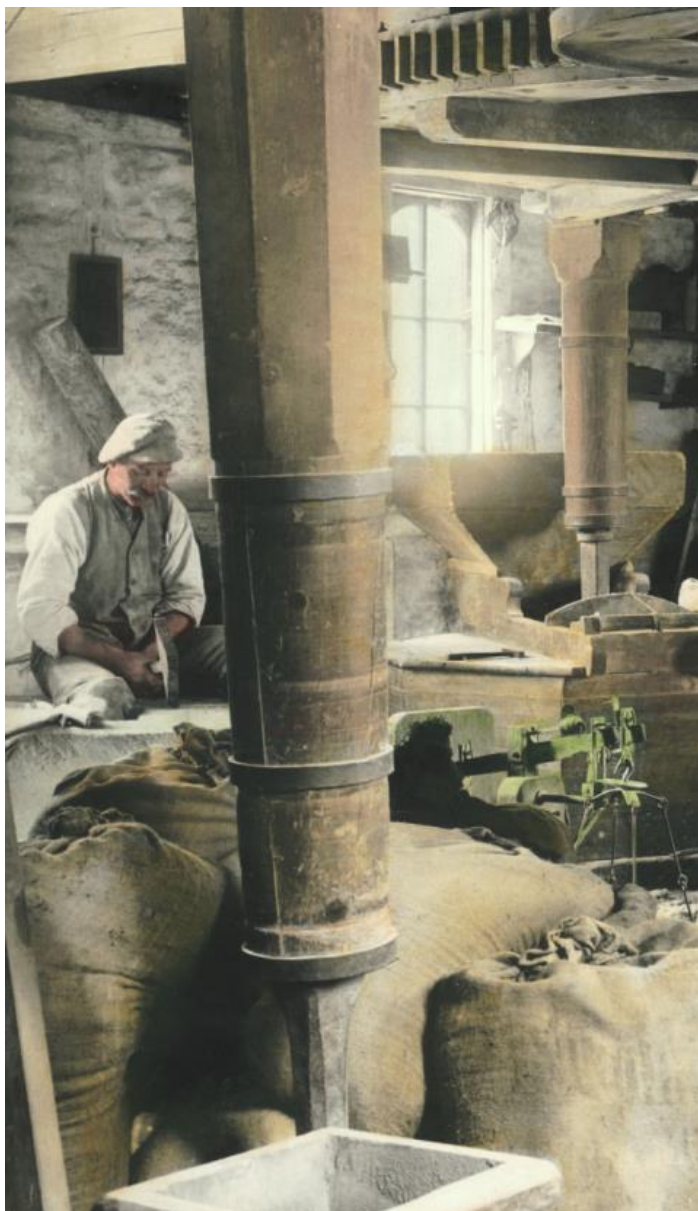
Udsnit af foto fra Over Knabberup Vandmølle, hvor møller Hans Rau er ved at bilde en af møllens kværne i 1917. Fremstilling af fint mel på de ældre stenkværne krævede en dygtig møller og vedligeholdelse af møllens kværnsten ved jævnlig bildning: Rillerne i møllestenene skulle vedligeholdes ved bearbejdning med en særlig bildehammer. Fra dias udarbejdet i marts 1973 af lærer Niels Chr. Rahbek, Skibet Skole (Vejle Stadsarkiv).
