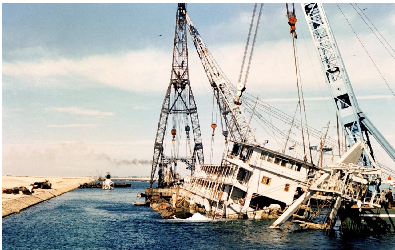
Her og på den følgende side ses eksempler på bjærgningen af de broer og skibe Egypten som modsvar på det israelsk-britisk-franske angreb havde sænket med sten og cement i Suezkanalen. Fotos fra UN Multimedia.
