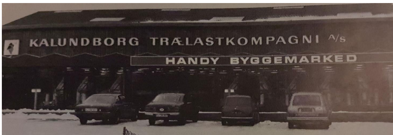
En klassisk måde at lave byggemarked på i 1970'erne. Nemlig ved at supplere en eksisterende ældre trælast med et byggemarked, der ofte henvendte sig til både private og professionelle kunder. Men det var især salget til private, der var i vækst. Kalundborg Trælastkompagni A/S 1976.
