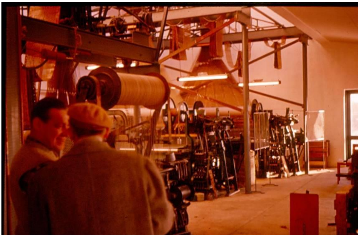
Øverst Pandrup Tæppefabrik under opførelse i foråret 1957. Arkitekt Bent Sørensen peger – stående sammen med Børge Møller. Nederst tæppefabrikant Arno Kovalleck, der fremviser de store tæppevæve som man havde kunnet installere kun 50 dage efter første spadestik ved fabrikkens opførelse. Privatfotos.
