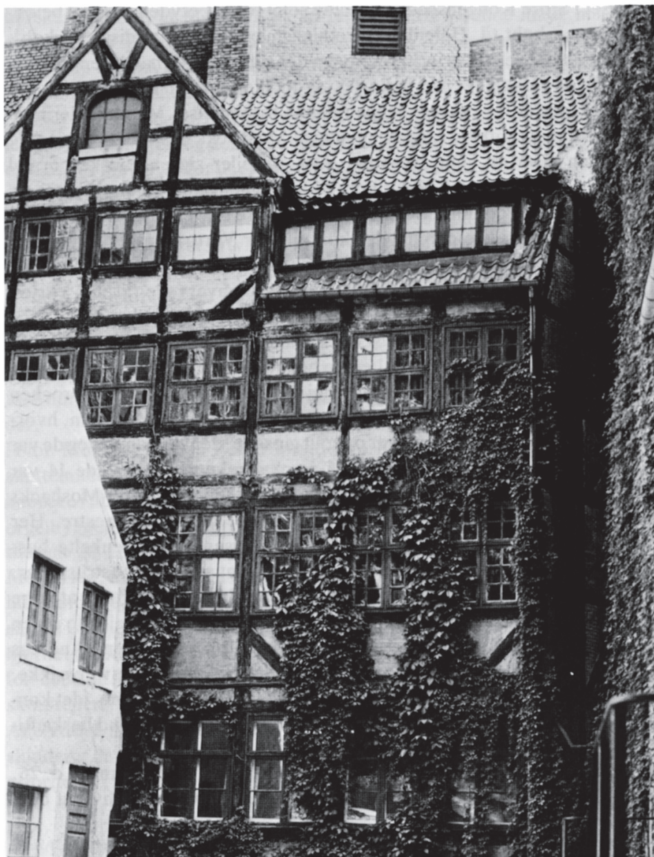
Ill. 6 Del af sidebygningen Skindergade mat. nr. 24, tidligere 25. Det var denne gård Moshack erhvervede i 1767. Forhuset opført 1730–34, sidebygning 1754–67. (Se iøvrigt: Historiske huse i det gamle København, Kbh. 1972, s. 201). - foto D.F.M.
