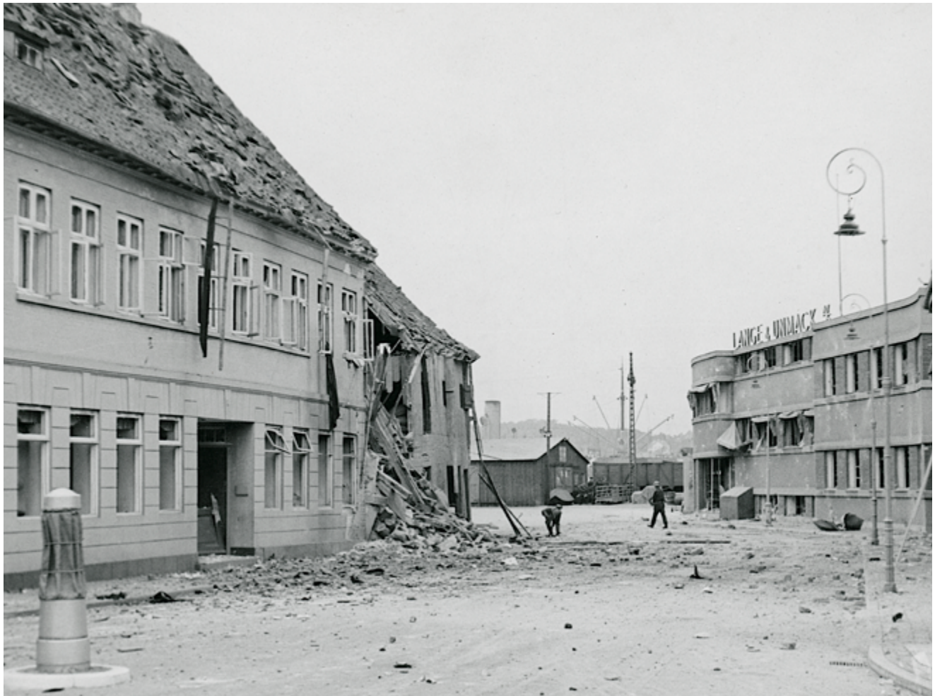
Slotsgade efter det upræcise bombeangreb på Aalborg 8. juli 1940. Foto: Frihedsmuseets Fotoarkiv
