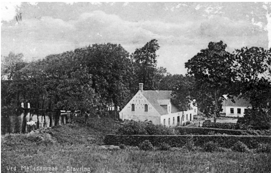
Støvring Møllegård, fotograferet 1920-1930. En del af dæmningen og mølledammen med svaner ses til venstre. Den høje dæmning med det opstemmede vand giver indtryk af, at møllegården ligger i en lavning. I huset med gavl, kvist og skorsten ligger en kornmølle bygget kort før 1800. Foto: Lokalhistorisk Arkiv for den tidligere Støvring Kommune.
