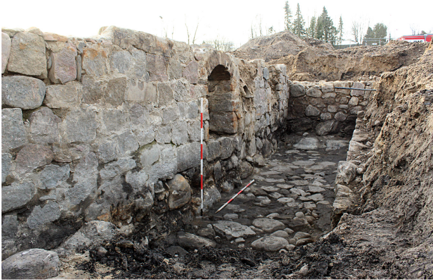
Ruinen af stampemøllen, som blev udgravet i 2021. Huset var bygget af kampesten kort før 1800, og fra 1874 lå hammerværket her. I den brolagte, forsænkede grav har gravhjulet og knastakslen til stamperne eller hamrene været. Foto: Nordjyske Museer.
