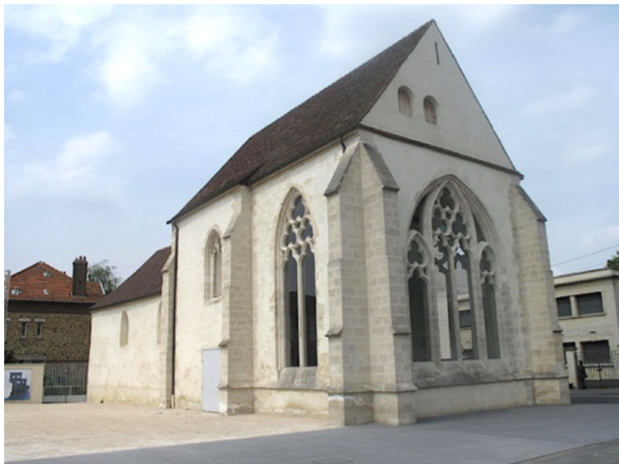
Les églises Sainte-Croix et Saint-Georges construites en enfilade dans l'enceinte de l'abbaye de Chelles: 4
