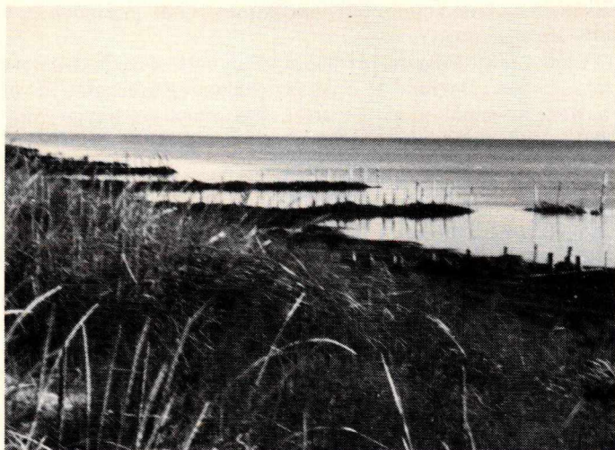
Høfder til beskyttelse af Overgårds østdiger set mod nord fra skellet mellem Overgård og Julianeholm 1980. Nogle af pælene er løftet af isen.
