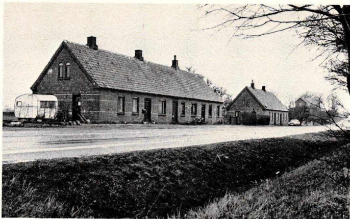
Grundmurede landarbejderboliger fra slutningen af 1800-tallet under Birkendegård ved Kalundborg. Det er et eksempel på, hvorledes mange af datidens landarbejdere boede i tilknytning til herregårdsmiljøet, og at de endnu kan ses forskellige steder i landet. Foto: G. Solvang 1982.
