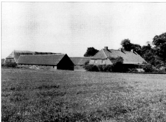
Den ældre grundmurede gård fra midten af forrige århundrede. Lyby, Salling.
