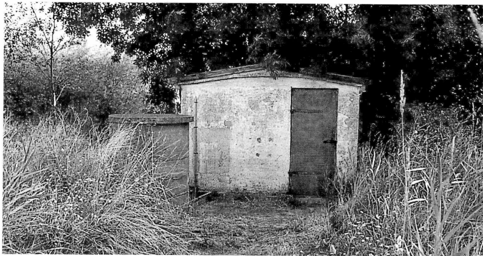
Fig. 19 viser det tredje pumpehus med pumpebrønd til venstre. Huset er er hvidkalket murstenshus med eternittag. Bagved huset findes stadig rester af den gamle betonkanal og jernsnegl, som anvendtes af vindmotoren. Foto: Morten Stenak 1999.
