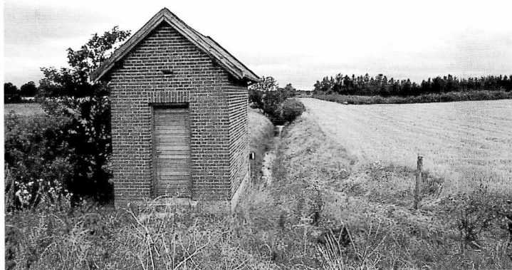
Fig. 18a viser pumpehuset nord for Hofmangsgave, hvor møllen stod. Foto: Morten Stenak 1999
