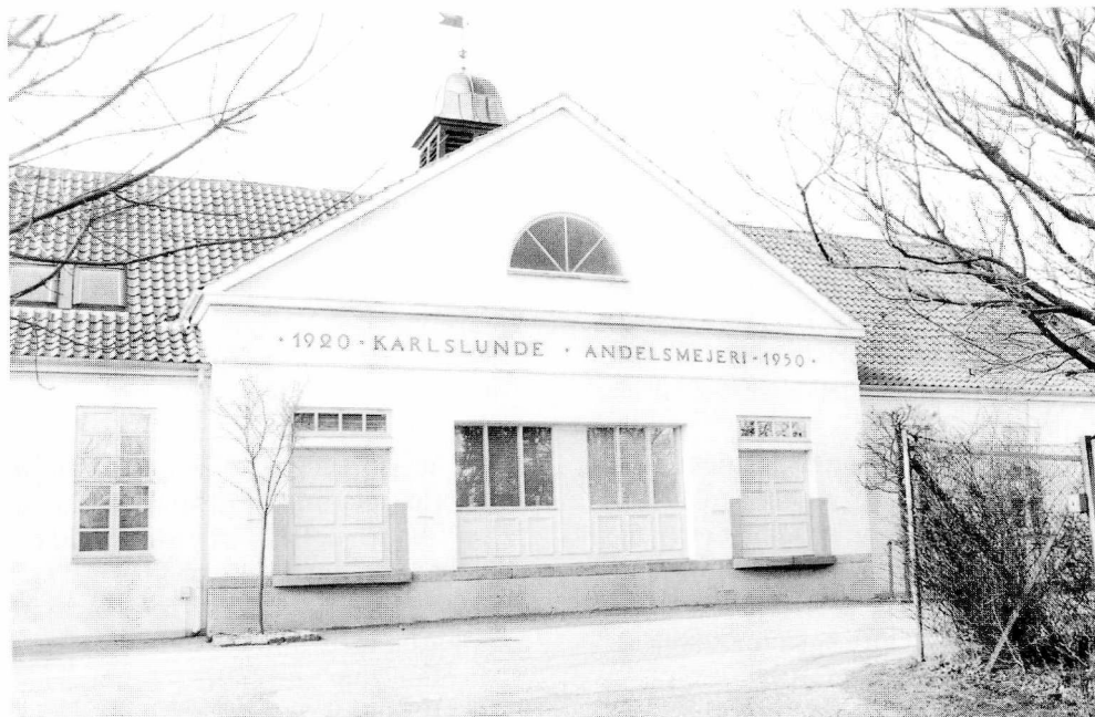
Fig. 9. Karlslunde Andelsmejeri. Mejeriet blev opført omkring 1900 og blev andelsmejeri i 1918. En restaurering i 1990'erne har betydet, at bygningen nu igen viser sig fra sin smukke side efter at have ligget hen i forfald efter at det var ophørt som mejeri omkring 1970. Foto: Gunver Brøndum Jensen.
