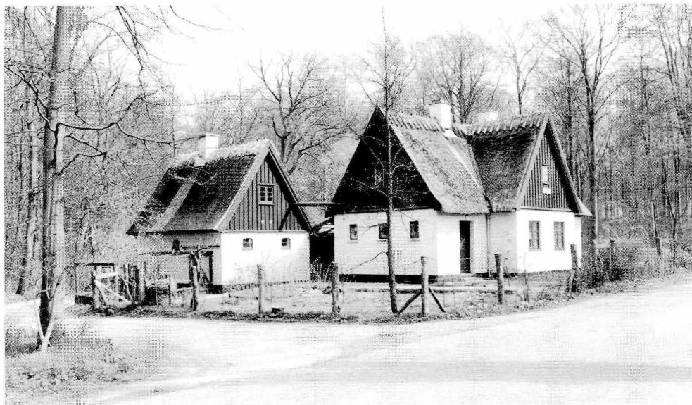
Fig. 5. Skovfogedsted ved Purlund hørende under Vallø gods. Herregårdene er fredede, men til herregårdsanlæggene hører også de mange mindre beboelseshuse, hvor arbejderne på godserne samt i skovene boede. Mange er meget smukt beliggende samt smukt proportionerede bygninger. Foto: Flemming Rasmussen.
