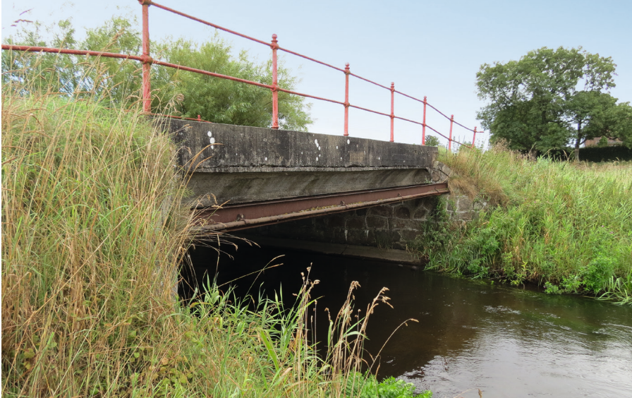
Abb. 9. Diese Brücke bei Hjartbro wurde 1918 von Pioniersoldaten gebaut. Sie gehörte zu dem Gebiet vor der Stellung, das für geplante Überschwemmungsmassnahmen vorgesehen war. Fig. 9. A bridge by Hjartbro built in 1918 by soldiers from the imperial army. It was part of the prepared flooding in front of the defence line.
