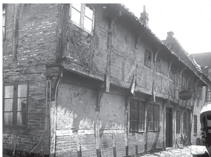
Fig. 3. Huset på Perlegade 21 fra sidst i 1500-tallet fremstod som et toetagers bindingsværkshus fra gårdsiden, mens det mod gaden havde en klassicistisk facade fra ca. år 1800.
