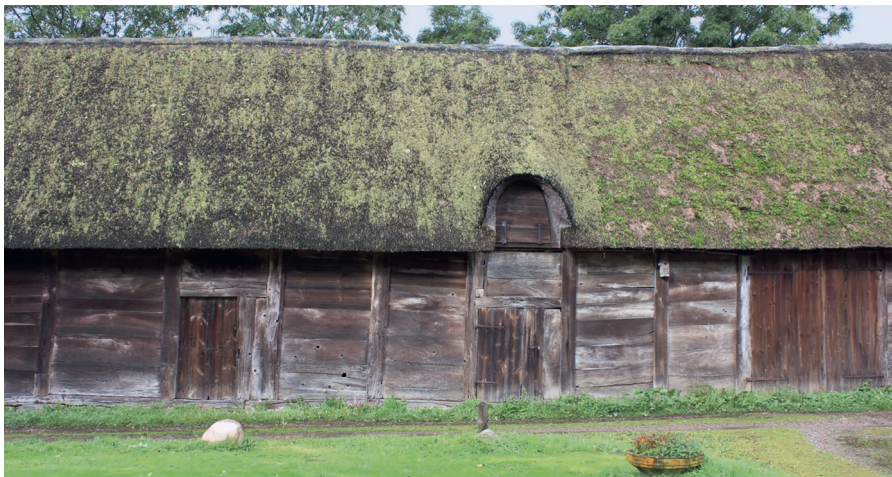
Fig. 1. Bullade af egetømmer fra 1668 e. Kr. på Christiansfeld-egnen i det nordøstlige Sønderjylland. Her ses princippet med vertikale stolper og svære horisontale planker, og man får et klart indtryk af en meget tømmerkrævende byggeskik (Foto: VisitKolding).
