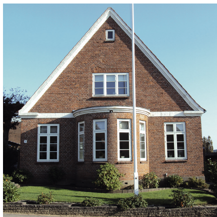
Fig. 12. Rolighedsvej 9, opført i 1927, er et typisk eksempel på et hus i Bedre Byggeskik, hvor man har gjort brug af røde teglsten, rødt tegltag, hvide vinduer og døre, samt hvide murværksdetaljer. Udtrykket er meget harmonisk og symmetrisk opbygget. Fig. 12. 9 Rolighedsvej was built in 1927. With its red bricks, white windows and doors it is a good example of the Bedre Byggeskik-houses in Haderslev.
