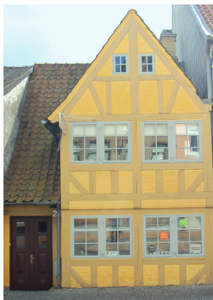
Fig. 2. Det gulkalkede bindingsværkshus på Naffet 24, oprindeligt opført som en del af en række på 11 boder.
