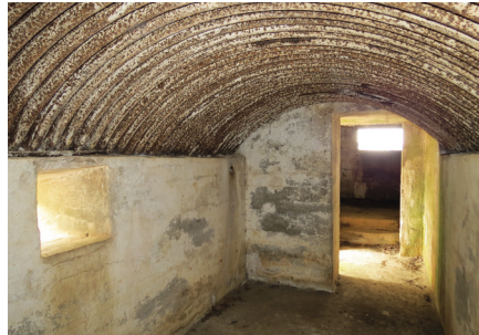
Abb. 5. Normalerweise waren die Decken aus Beton, aber es gab zusätzlich Verstärkungen aus Eisenplatten wie zum Beispiel in diesem Bunker bei Pothøj. Der Bunker hatte Platz für eine 37 mm Revolverkanone mit Bedienungsmannschaft. Die Revolverkanone leistete bis zu 50 Granaten pro Minute auf bis zu 2000 m Entfernung.
