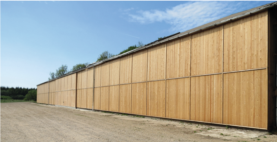
Abb. 14. Der Flugzeughangar bei Tondern heute. Fig. 14. The hangar by Tønder today.
