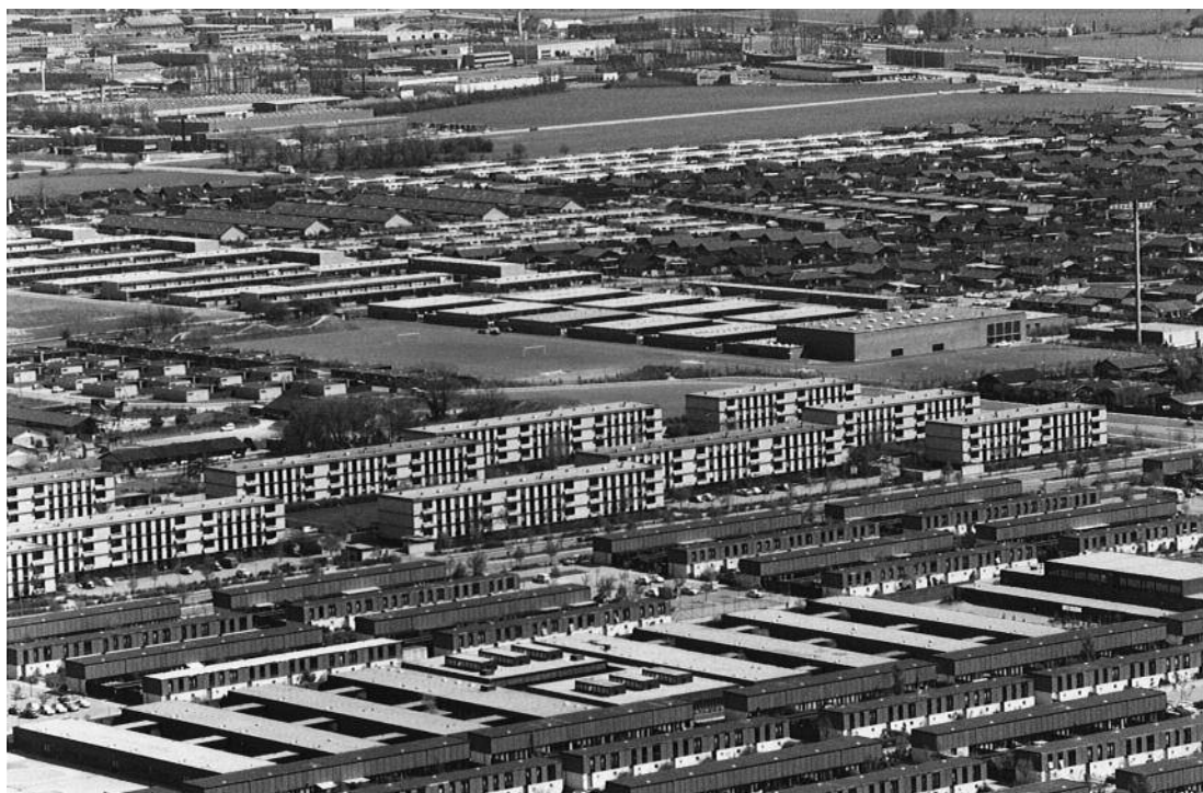
Udsigt over Albertslund Syd og Vallensbæk Nordmark i midten af 70'erne. Forstaden opstod i løbet af godt 10 år og blev, med stationscenter, almennyttige gårdhavehuse og lavere blokbebyggelser, et af tidens øvrige forstadsideal. (Vallensbæk Bibliotek).
