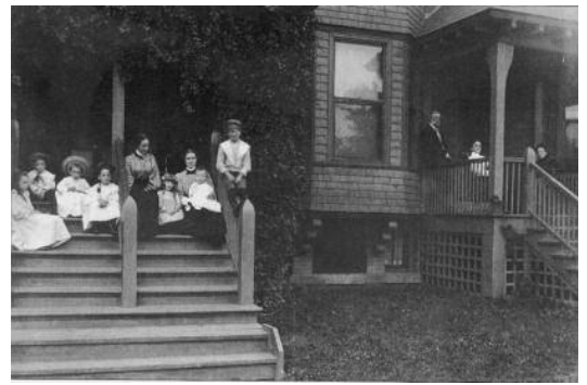
Foto af arbejdernes boligforhold mv. i Pullman City omkring 1890. (Frank Beberdick, Chicago's historic Pullman district , s. 111)
