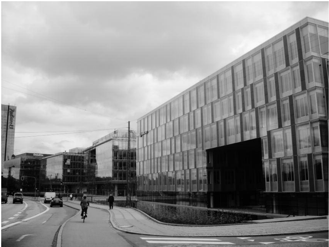
Bygninger med store glasfacader og åbne kontorlandskaber har også i Danmark set stor udbredelse. På Ny Tøjhusgrunden i København blev der i 2007 opført 4 store trendsættende bygninger: Hovedkontoret for Kommunernes Landsforening, HK Danmark-huset samt Deloittes og Simcorps hovedkontor. Alle bygningerne er præget af glasfacader og åbne kontorlandskaber. Foto: Jan Friis, 2012.
