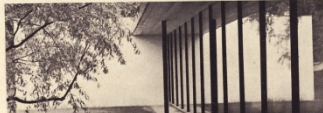
Et af de store glasvægge i „Lusthaus“-huset i Huelsholt, der er opført efter tegninger af Jørgen Bo og Vilhelm Wahlert. Glasvæggen er beskyttet af det brede udgang, der er belagt med træark.
