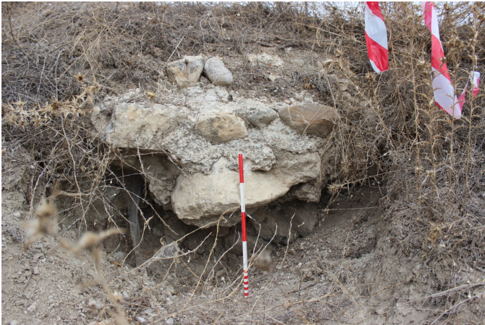
Fig. 12 – Rester af fundamentet i cement og mørtel blotlagt i skråningen syd for anlægget. Foto af forfatteren.
