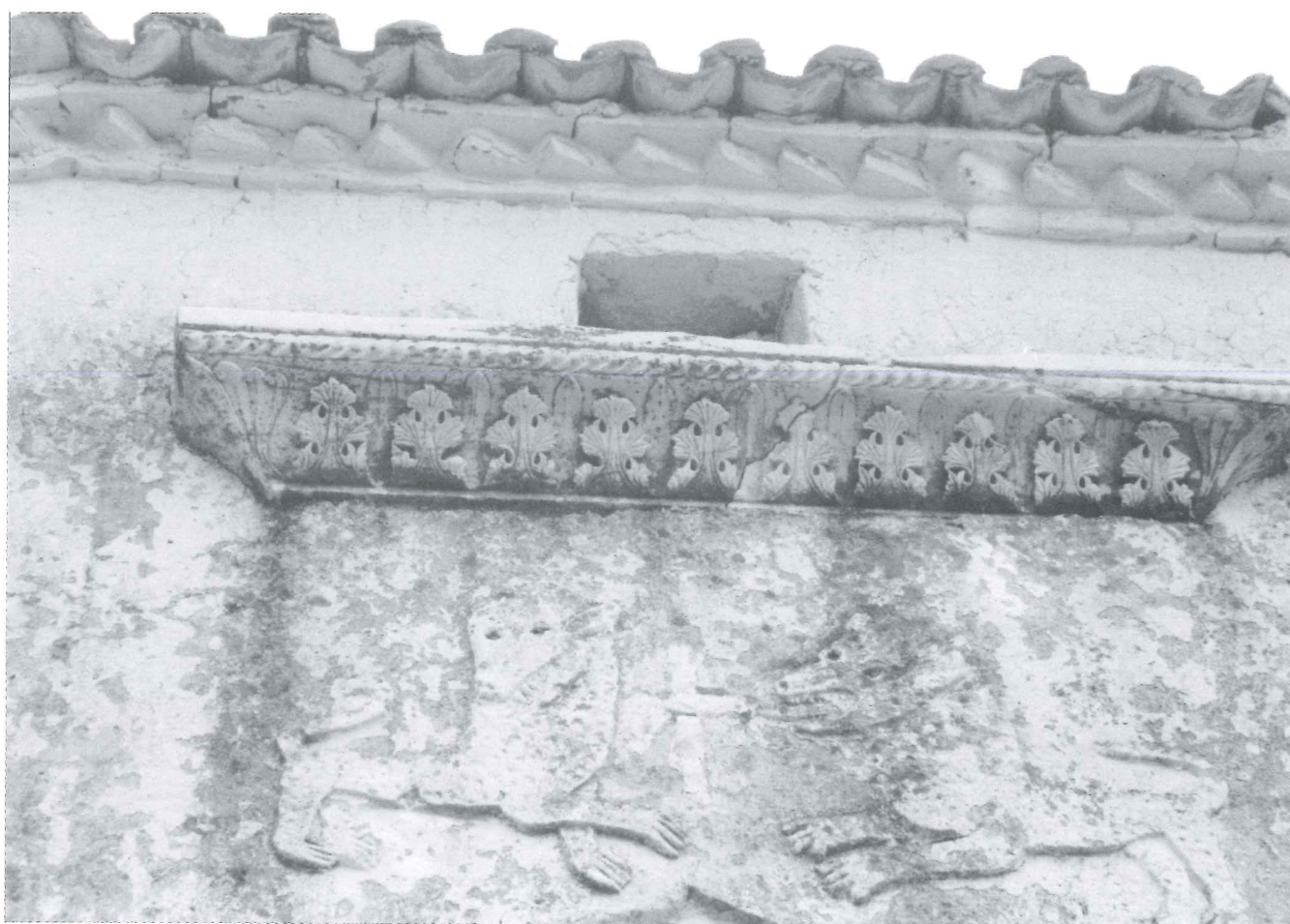
Fig. 14. Agia Pelagia. Cornice. On site.
