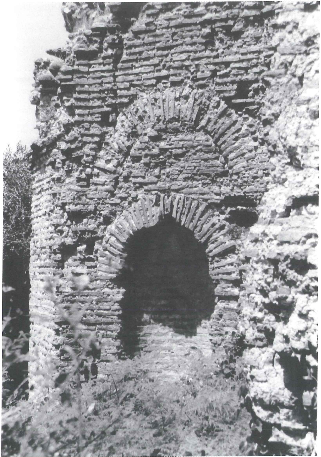
Fig. 3. Riza. Decagon. Niche at the interior.
