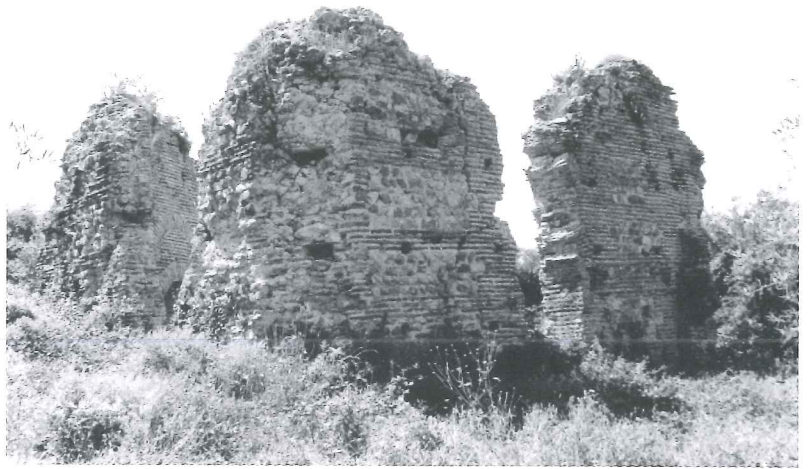
Fig. 2. Riza. Decagon (RoomA). The west side.
