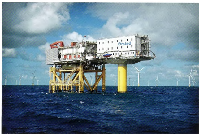
Figur 3. Beboelsesplatformen ved Horns Rev 2 er verdens første af sin slags. Den ligger ca. 30 km fra land og 70 meter over havet blandt parkens 91 havvindmøller. Vindteknikere bor her en uge ad gangen.
