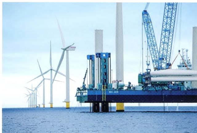
Figur 1. Opførelsen af Anholt Havmøllepark i 2012-13. Parkens samlede kapacitet er på 400 MW svarende til 400.000 danske husstandes årlige forbrug.
