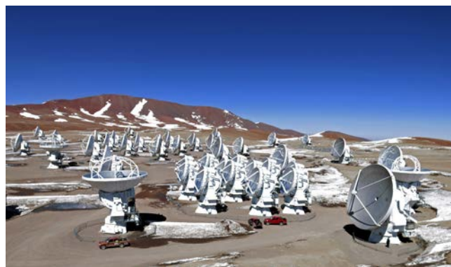
Figur 2. Atacama Large Millimeter/submillimeter Array (ALMA) på et plateau i Atacamaørkenen i Chile i ca. 5000 m højde. ALMA består af 66 antenner med en diameter på 12 m, der kan flyttes rundt, så man kan simulere et teleskop med en diameter på op til 16 km (ESO).
