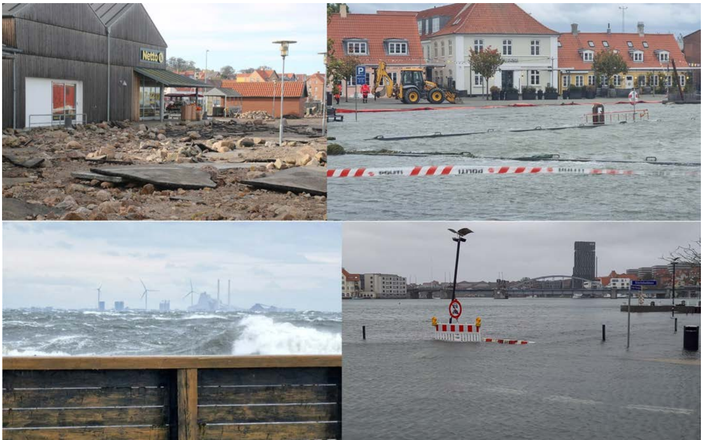
Figur 1. Fotos fra stormfloden oktober 2023. Øverst fra venstre: Folkemødepladsen i Allinge ødelagt af bølger (Foto: Peter Aakjær). Høj vandstand i Køge Havn (Foto: Sebastian Pelt). Nederst fra venstre: København set fra Mosede Havn (Foto: Martin Stendel). Sønder Havnegade i Sønderborg (Foto: Tine Knudsen).
