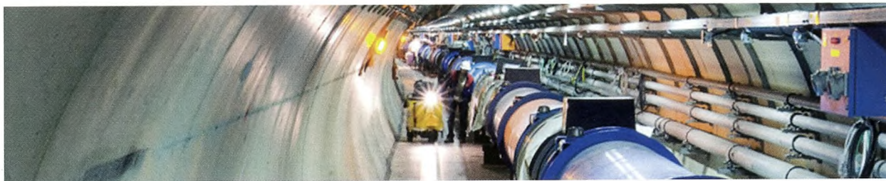
Figur 3. Verdens længste vakuumkammer (med et tryk på under 10^{-12} mbar) har en omkreds på 27 km. Røret i midten indeholder et indre rør for protonstrømmen på 7 TeV, der holdes på plads af superledende magneter med en temperatur på 1,9 K [3].
