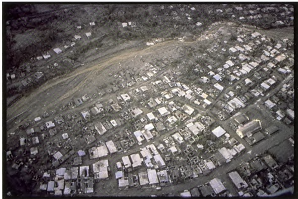
Figur 4. Ødelæggelser i kølvandet af Pinatubo-udbruddet: Tage kollapsede i hobetal, og vulkanaske blandet med regnvand førte til meget destruktive mudderstrømme, såkaldte lahars [2].
