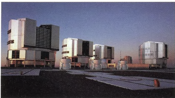
Figur 2. Very Large Telescope består af fire teleskoper på hver 8,2 m (diameter). De fire teleskoper er forbundet med hinanden via en serie underjordiske tunneller, som samtidigt forbinder dem med en række mindre teleskoper (ESO).
