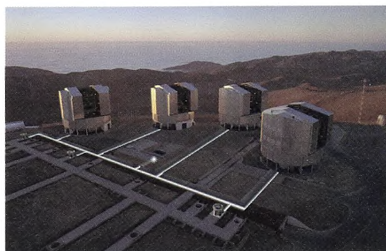
Figur 10. Tunnellerne på Cerro Paranal som sikrer at teleskoperne kan anvendes til interferometriske målinger (ESO).
