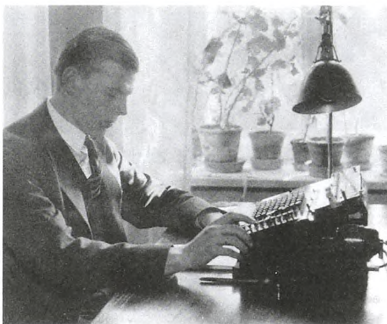
Figur 4. Her benytter Bengt Strömngren i 1930'erne en elektrisk regnemaskine, som kunne multiplicere eller dividere to store tal med hinanden på omkring et minut. Dengang var en sådan maskine en avanceret og ret kostbar sag. Fra [6].
