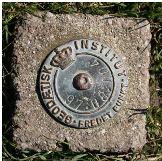
Figur 3. Tredjeordens fikspunkt centreret i bronzeplade i jordhøjde over nedsat betonblok. Stationscentret er centret af bronzepladen. Fra toppen af Jernhatten på Djursland. Foto: Wikipedia.
