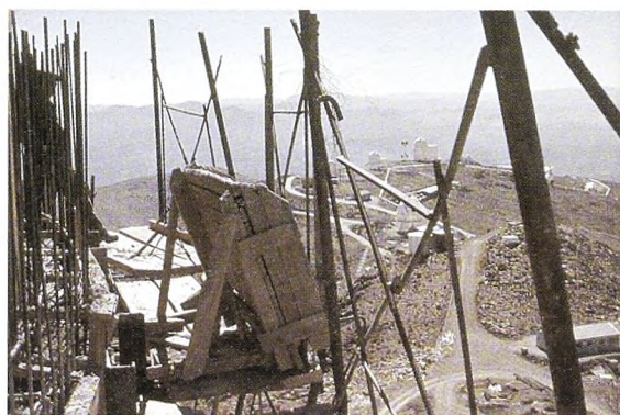
Figur 3. 3.6m teleskopets kuppelbygning som åben byggeplads i 30m højde (forf. foto, september 1974).
