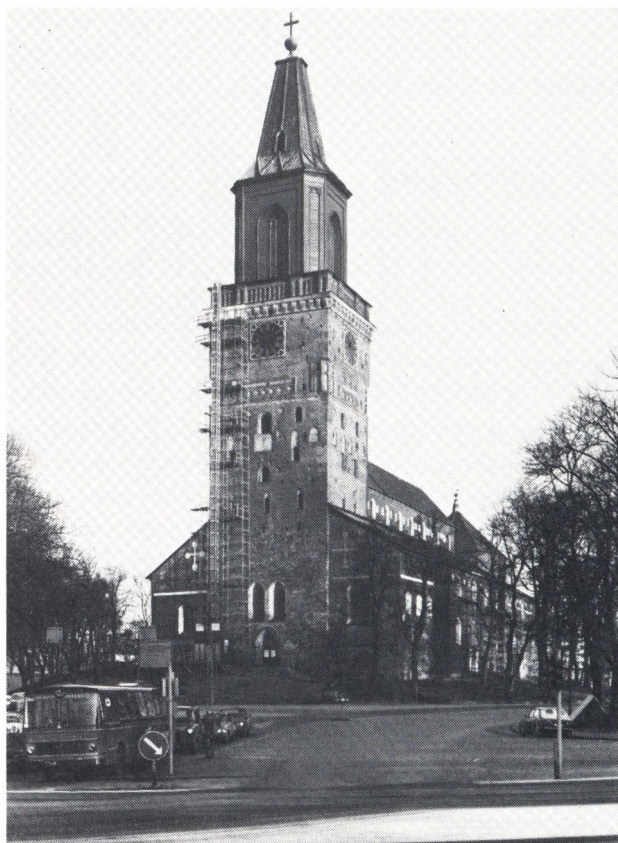
Fig 3. Åbo domkyrka under de senaste restaureringsarbetena år 1978.
